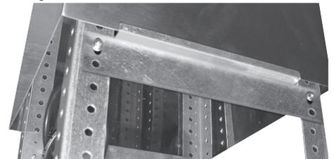
Nachdem das erste Halblech befestigt wurde, muss noch das zweite Halblech in der gleichen Weise an der gegenüberliegenden Seite befestigt werden.
